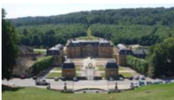
Le château de Dampierre avant les travaux de réhabilitation (Source dossier d'enquête publique)
