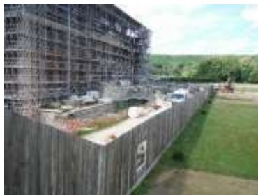
Le château en phase de réhabilitation
